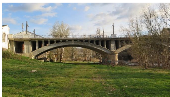
Pont de Sant Vicenç sobre el Llobregat
